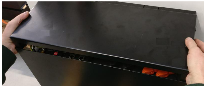
Figura 75 – Installazione coperchio WALL-BOX
