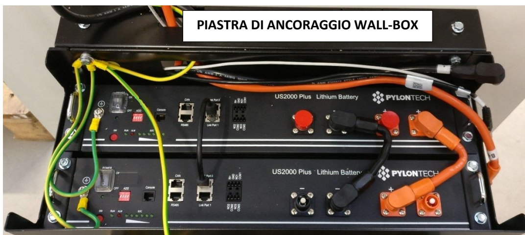
Figura 14 – WALL-BOX ad installazione completata
