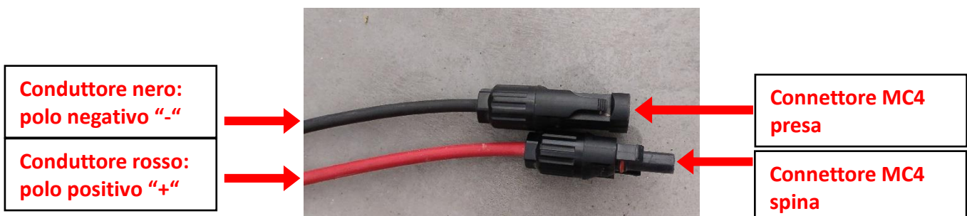
Figura 35 - Cavi in derivazione dal quadro di stringa intestati con connettori MC4
