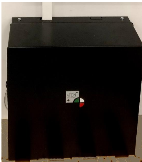
Figura 8 - WALL-BOX al termine dell'ancoraggio
