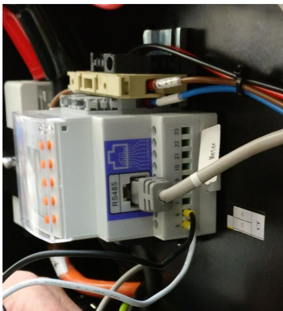
Figura 33 – Collegamento dei 2 cavi del sensore CT sul Meter Acrel
