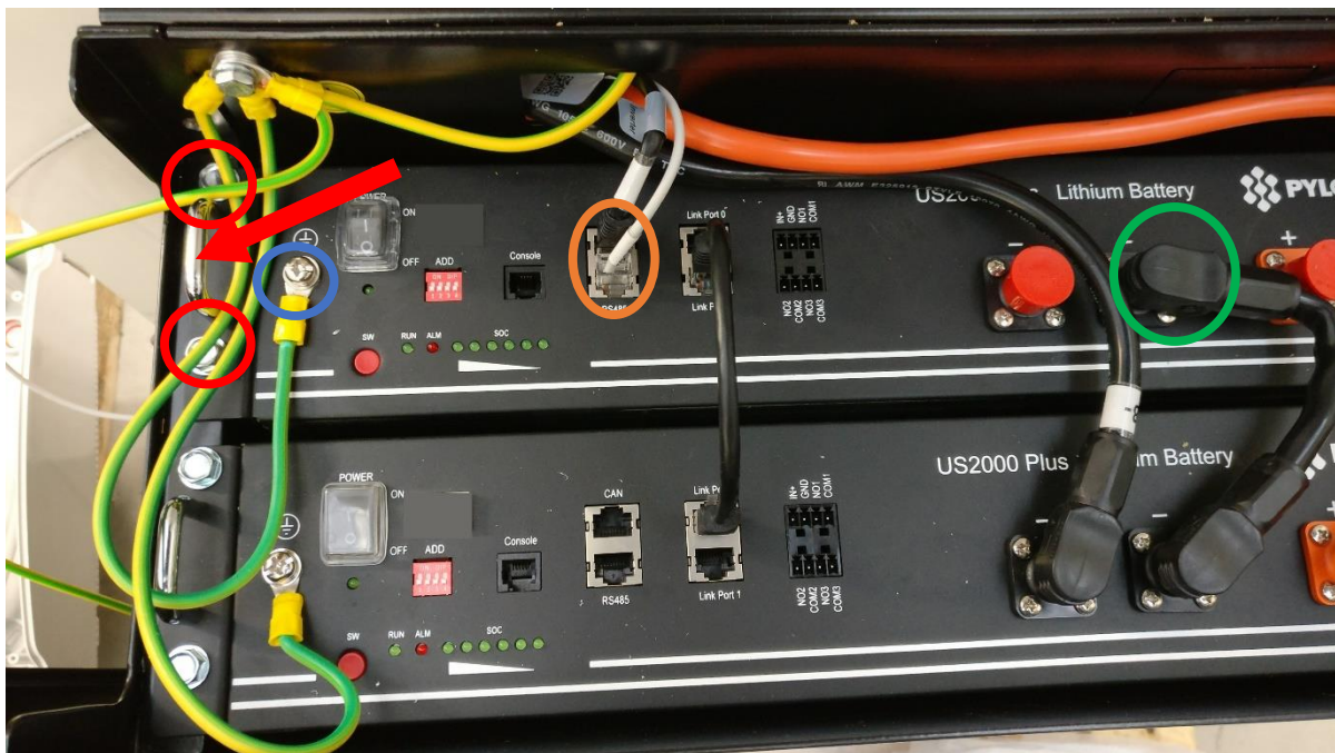
Figura 76 - Sostituzione modulo batteria - Rimozione viti fissaggio modulo, vite collegamento equipotenziale, cablaggi di segnale e potenza.
